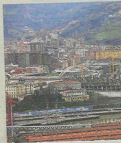
Enero de 2013. El nuevo campo alcanza su cota máxima. Por dentro, los operarios comienzan a colocar las gradas.
