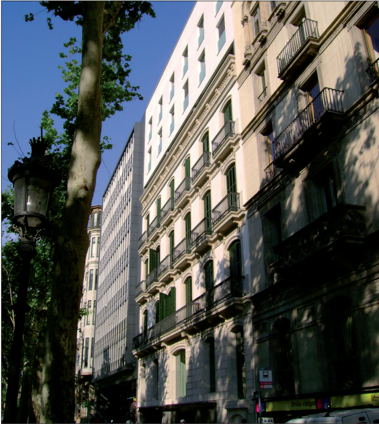
Las Arcadias Gran Vía de Tècnics G3
